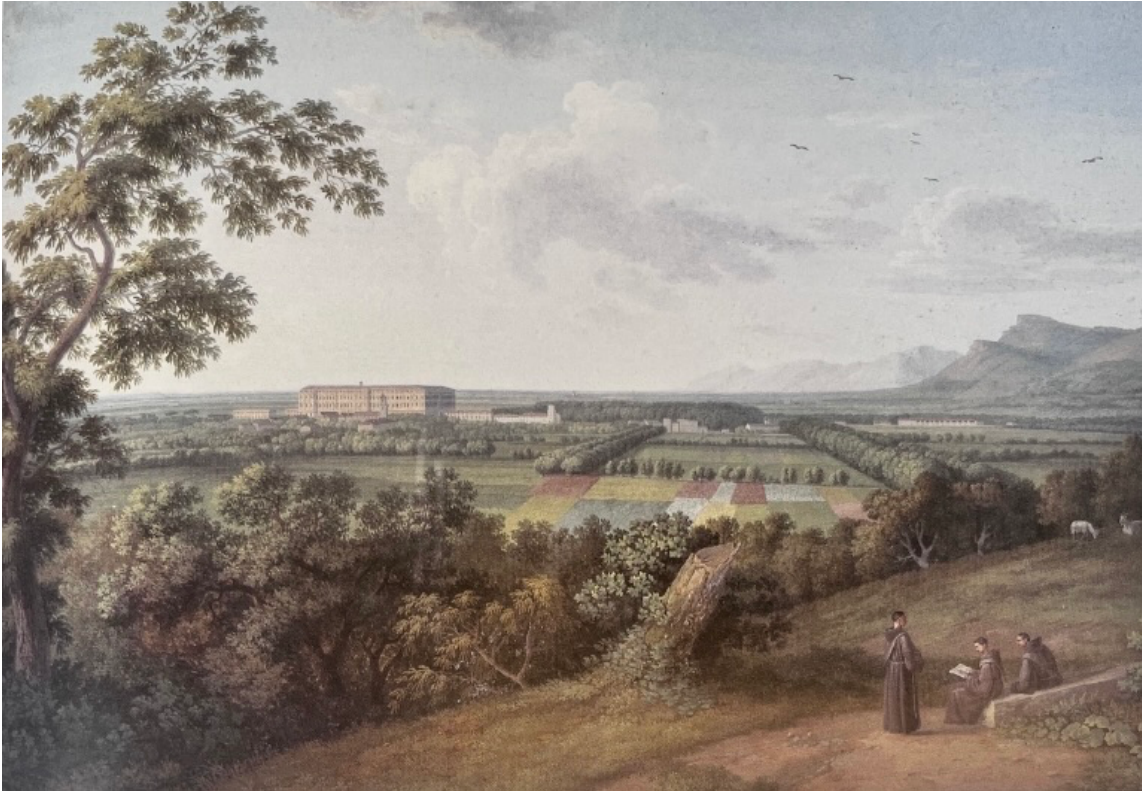
La Reggia di Caserta dal Convento dei Cappuccini, 1782, Caserta Palazzo Reale
